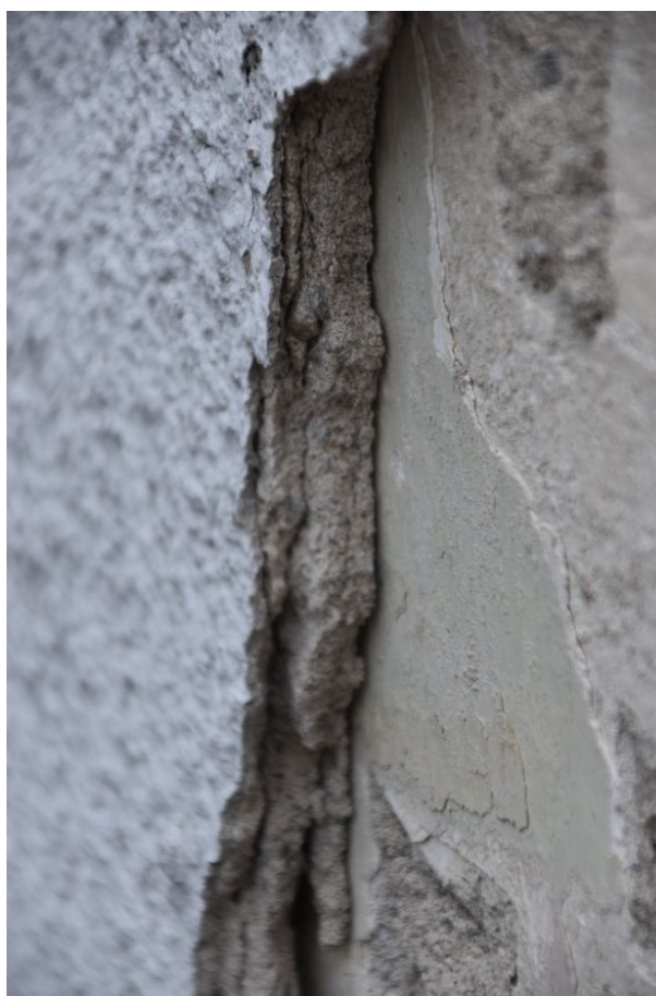
fot. 47: Nawarstwienia w odkrywce nr 34.
