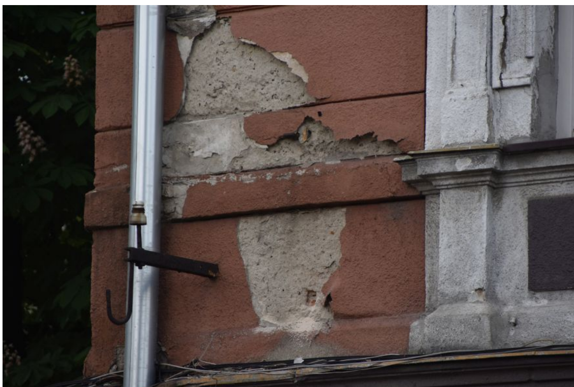
fot. 20: Odkrywka nr 10, elewacja północna.
