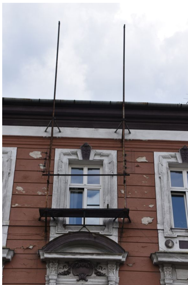
fot. 50: Maszty przytwierdzone do elewacji, czwarta oś elewacji frontowej.
