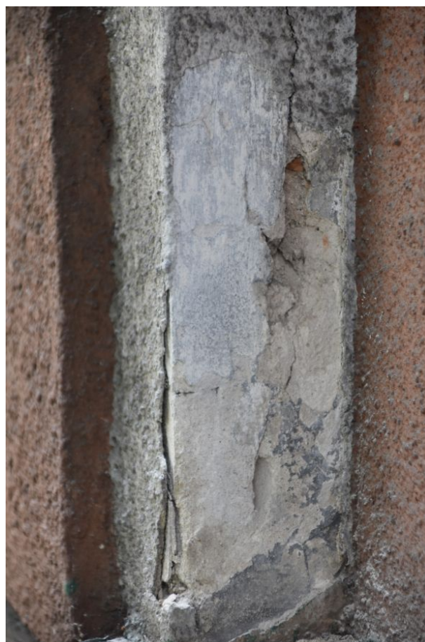
fot. 41: Odkrywka nr 18, elewacja wschodnia.
