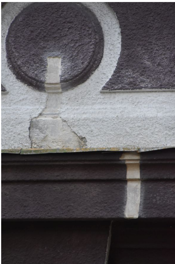
fot. 22: Odkrywka nr 30, elewacja zachodnia.
