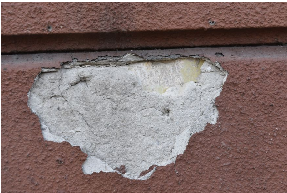
fot. 6: Odkrywka nr 4, elewacja frontowa.
