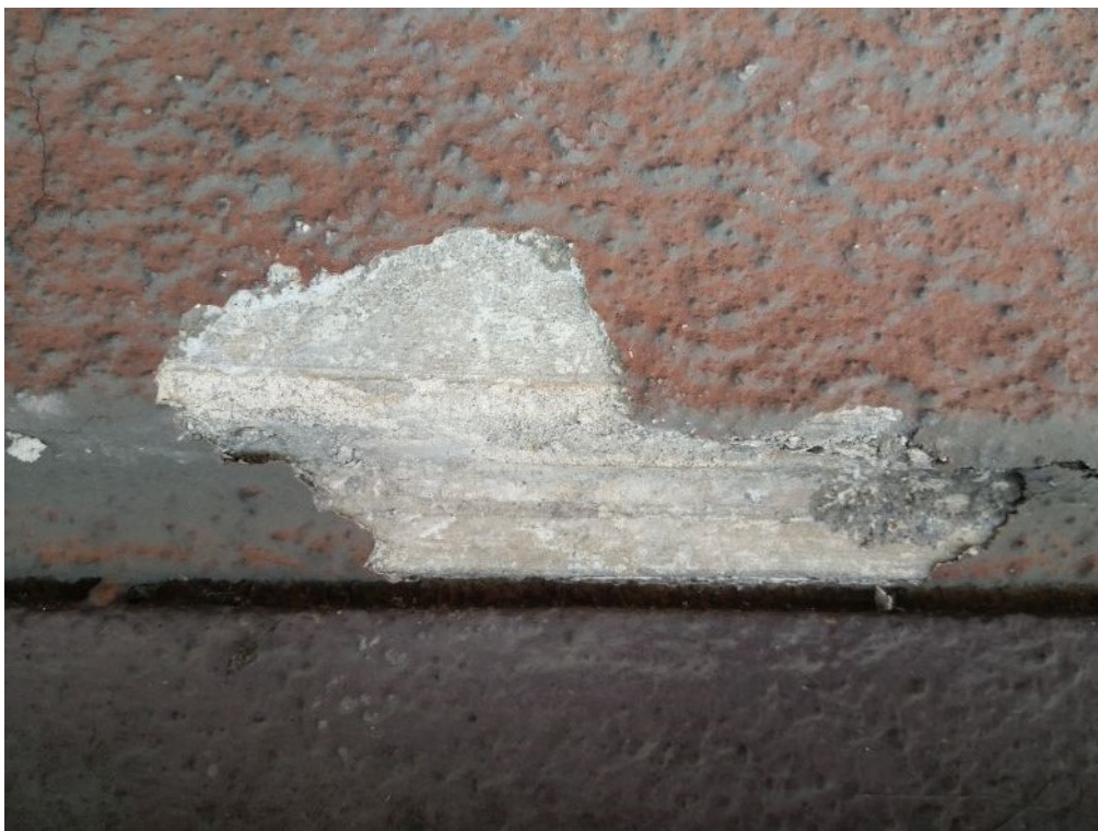
fot. 3: Odkrywka nr 1, elewacja frontowa. Poszerzona odkrywka naturalna ujawniła profilowanie cokołu skryte pod warstwą współczesnego tynku.
