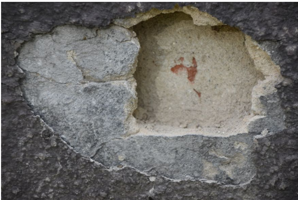
fot. 5: Odkrywka nr 15, elewacja wschodnia.
