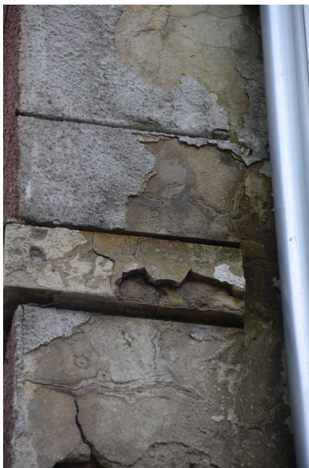
fot. 15: Naturalna odkrywka nr 33, elewacja południowa. Odsłonięte zostały poszczególne warstwy.
