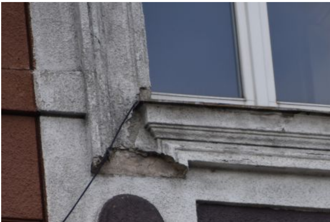
fot. 42: Naturalna odkrywka w obrębie opaski okiennej, oś siódma elewacji frontowej, drugie piętro.
