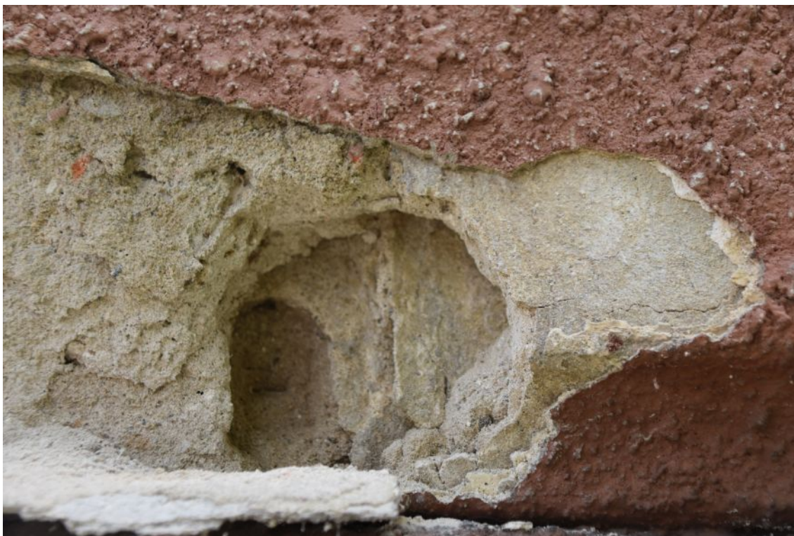
fot. 8: Odkrywka nr 27, elewacja zachodnia.
