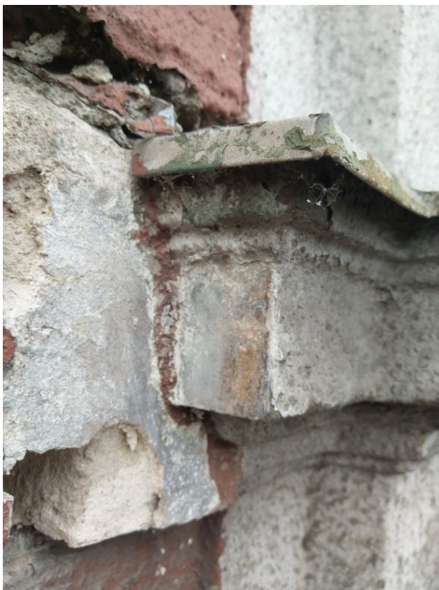
fot. 40: Odkrywka nr 11, elewacja frontowa.
