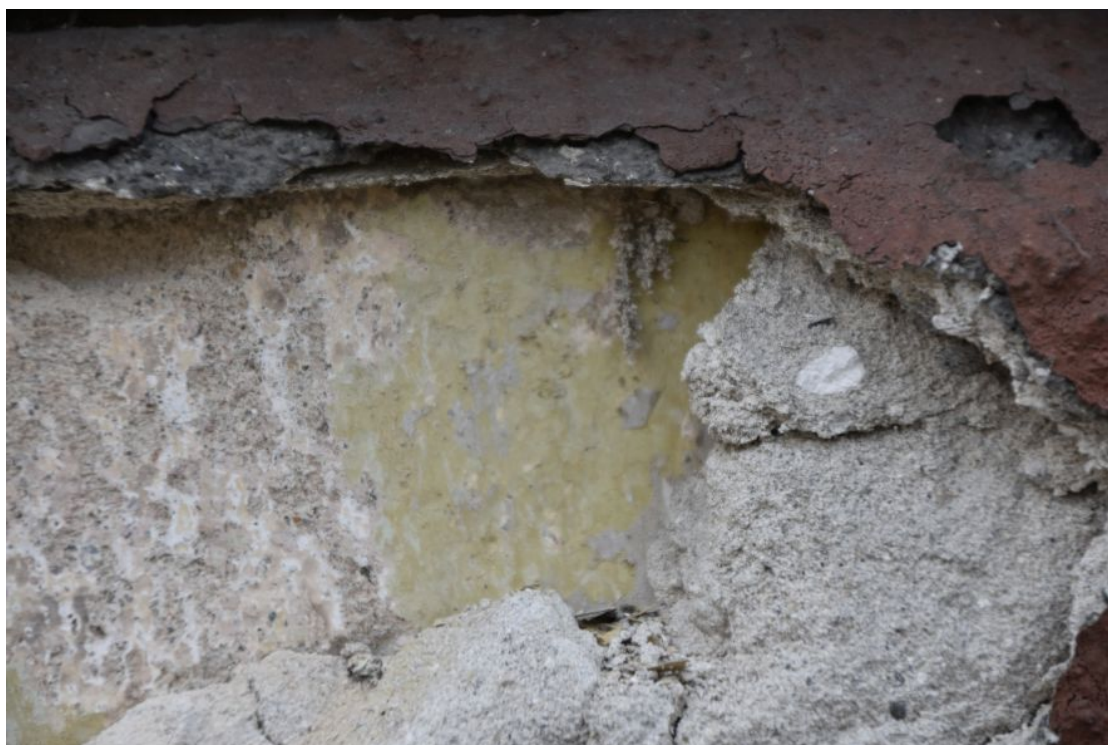
fot. 7: Odkrywka nr 4, elewacja frontowa.
