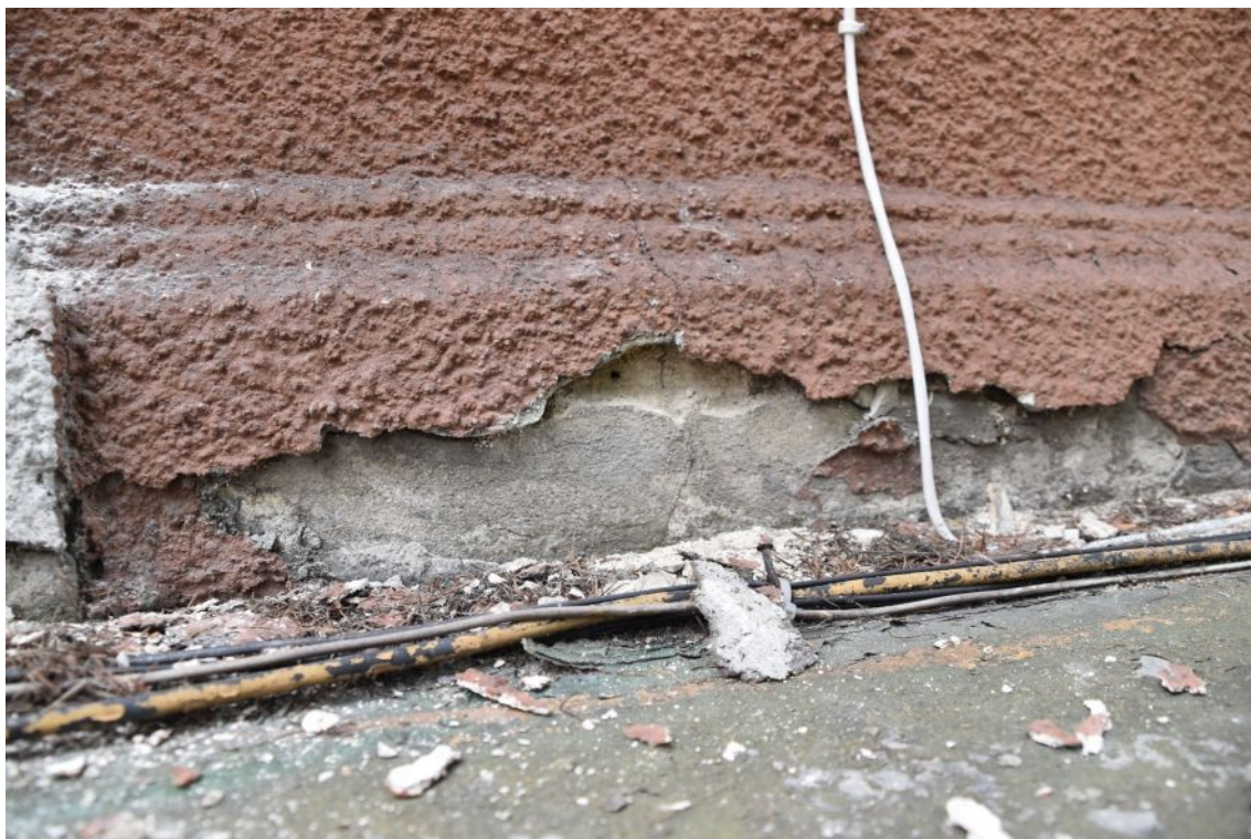
fot. 21: Odkrywka nr 23, elewacja wschodnia.
