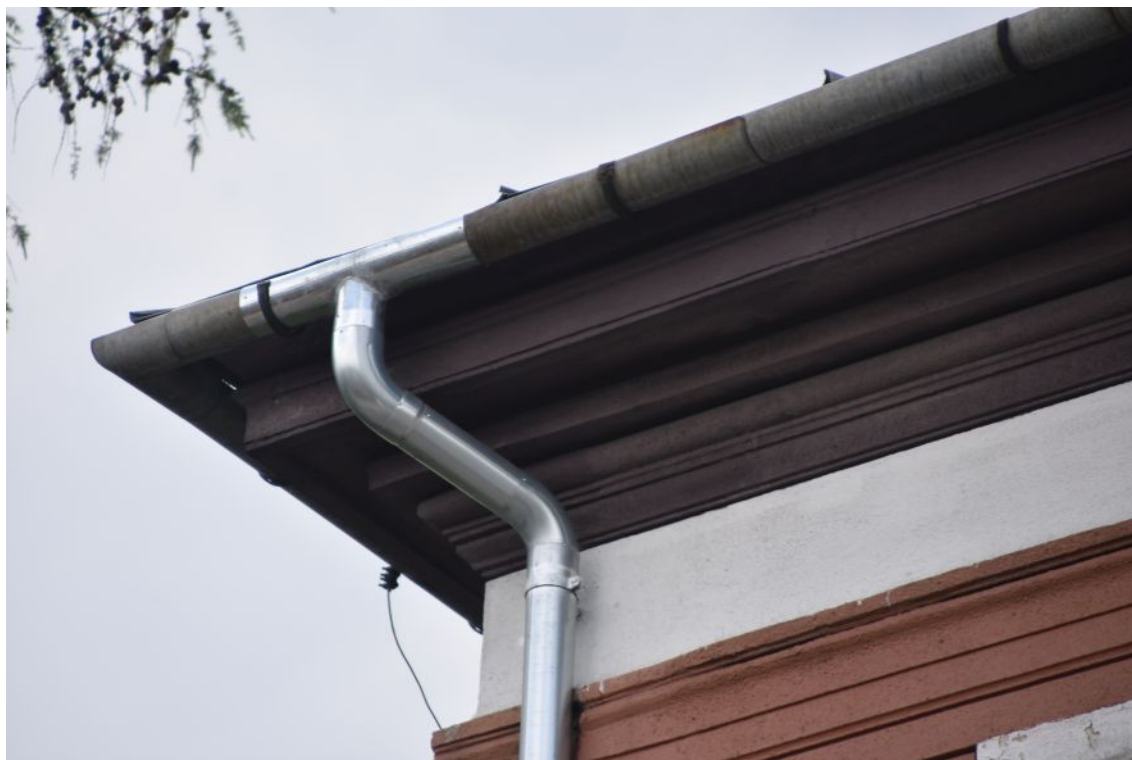
fot. 51: Rury spustowe zostały częściowo wymienione.
