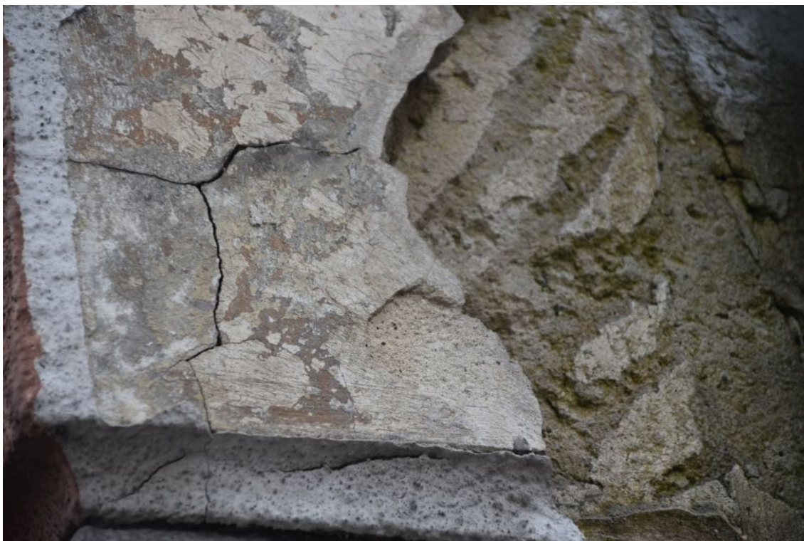
fot. 12: Naturalna odkrywka nr 33, elewacja południowa. Odsłonięte zostały poszczególne warstwy. Po prawej stronie widoczne nasieki wykonane w pierwotnej warstwie tynku.
