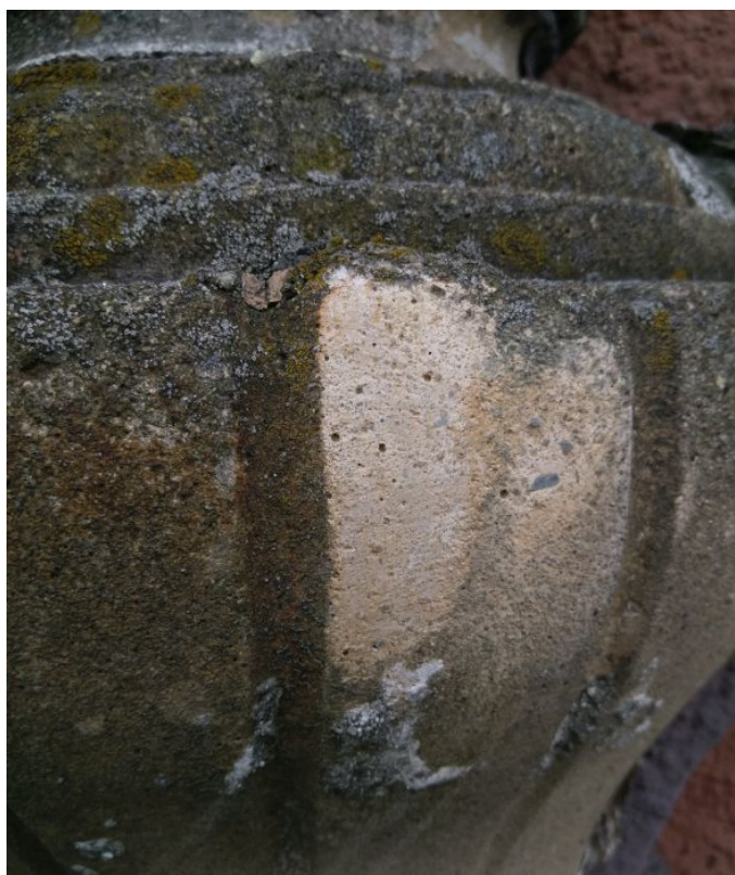
fot. 37: Odkrywka nr 9.
