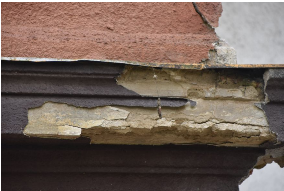
fot. 28: Naturalna odkrywka nr 5, elewacja frontowa.
