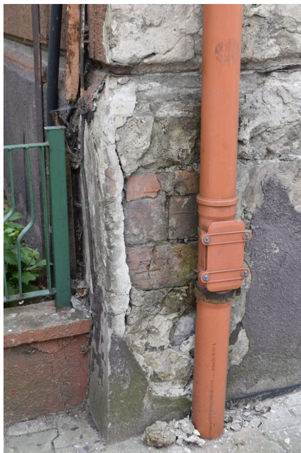
fot. 4: Odkrywka nr 3, elewacja frontowa.
