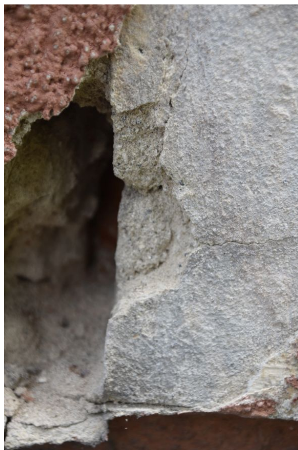
fot. 9: Odkrywka nr 28, elewacja zachodnia.
