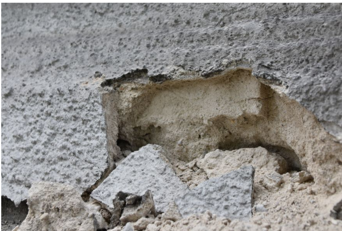
fot. 43: Odkrywka nr 7, elewacja frontowa, opaska okienna.
