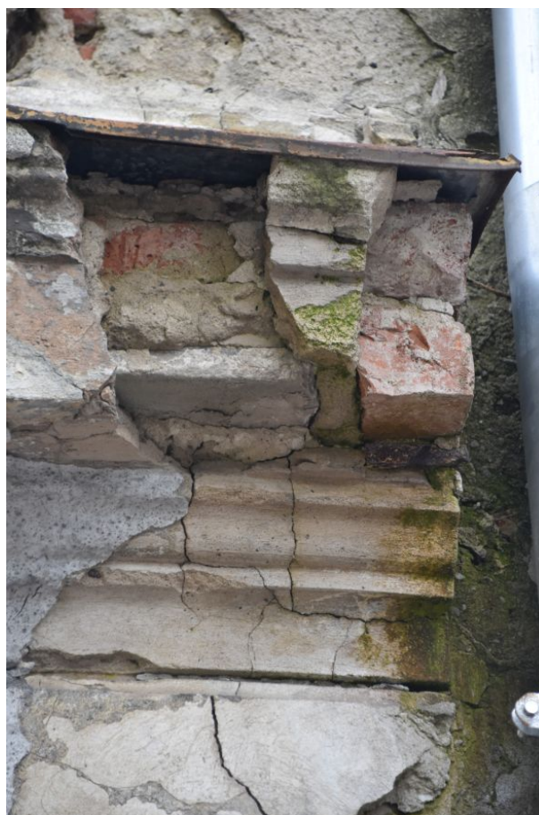
19 fot. 13: Fragment gzymsu ujanwiony w odkrywce nr 33.
