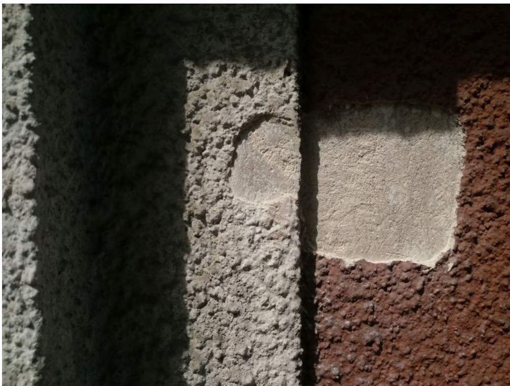
fot. 38: Odkrywka nr 24, elewacja zachodnia. Fragment opaski okiennej (po lewej) oraz elewacji (po prawej).
