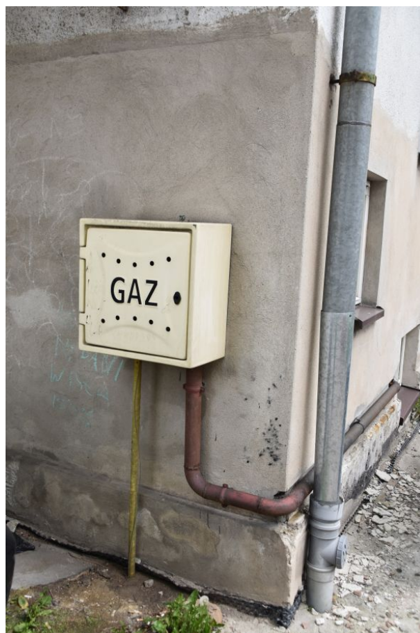
fot. 64: Ściana zachodnia ryzalitu. Skrzynka gazowa.
