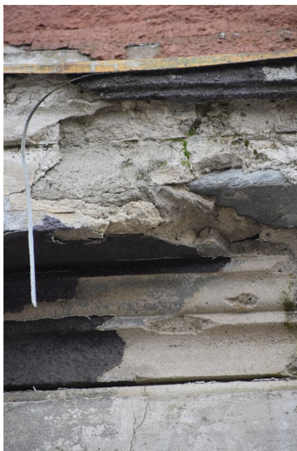
fot. 29: Naturalna odkrywka nr 5, elewacja frontowa.
