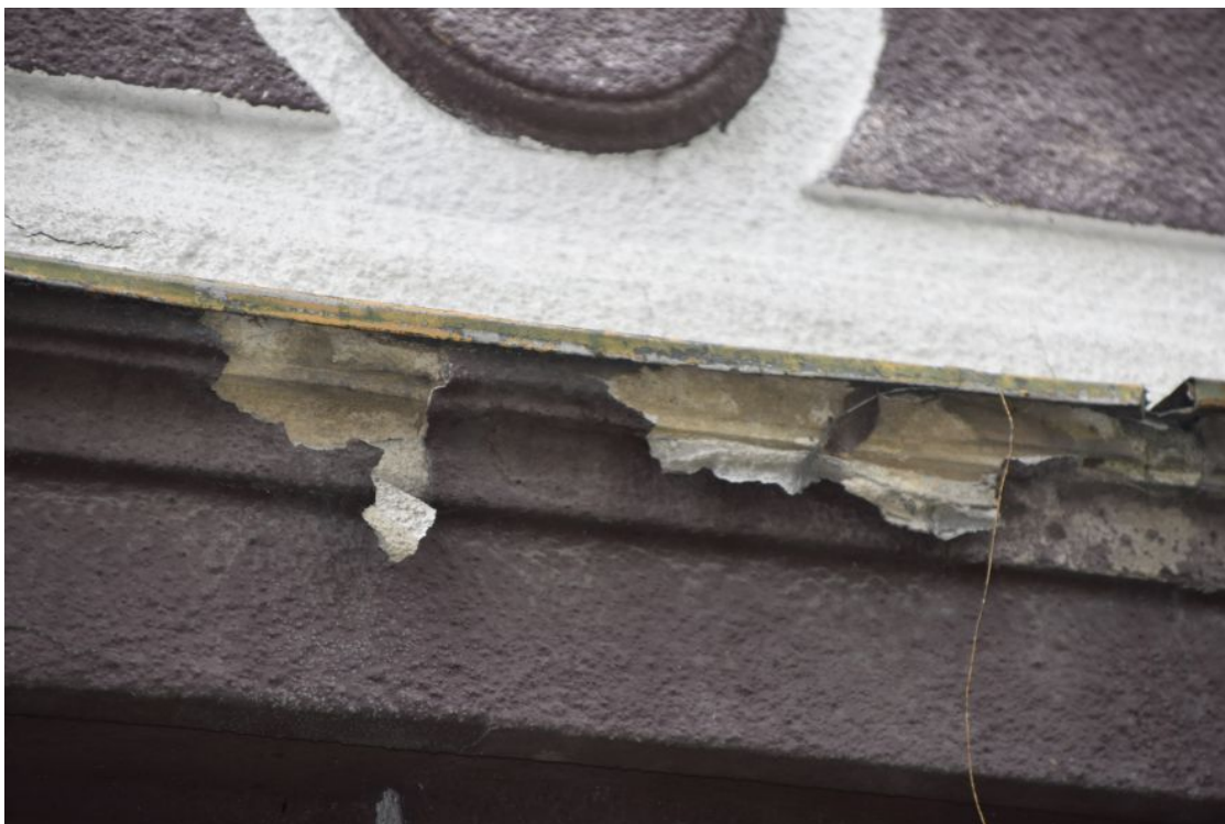
fot. 24: Odkrywka nr 22, elewacja wschodnia.
