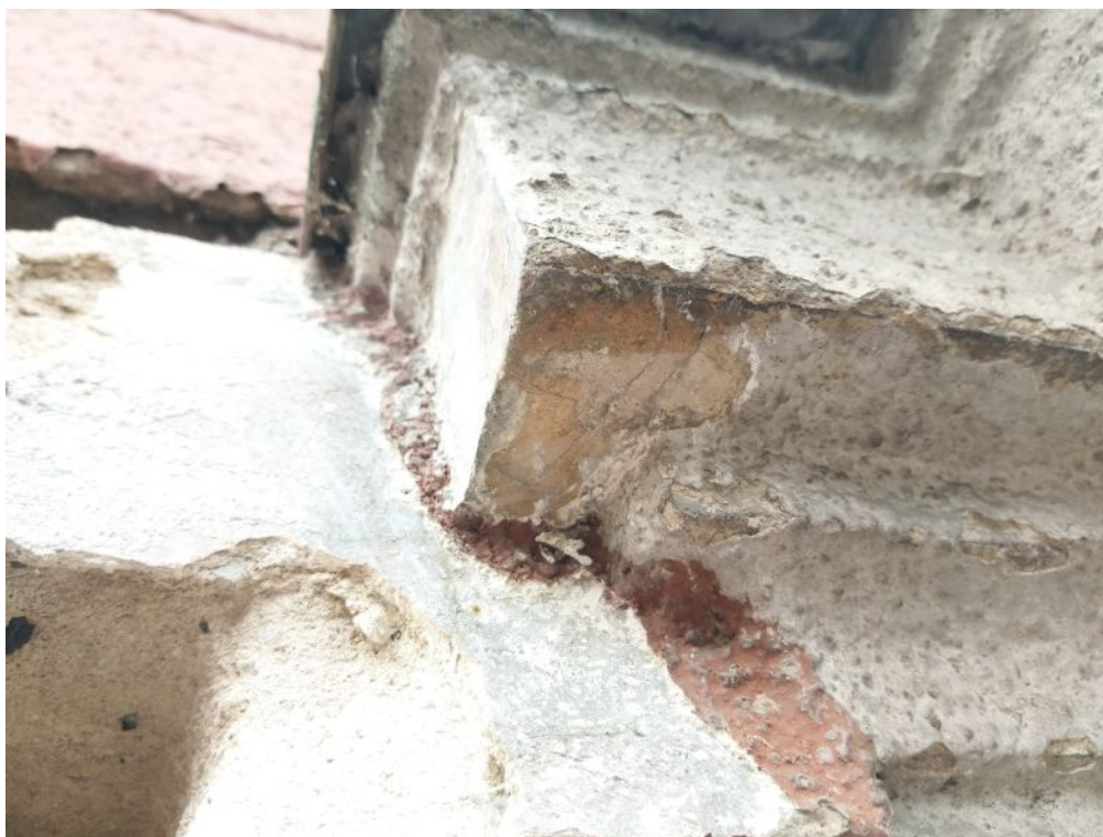
fot. 39: Odkrywka nr 11, elewacja frontowa.
