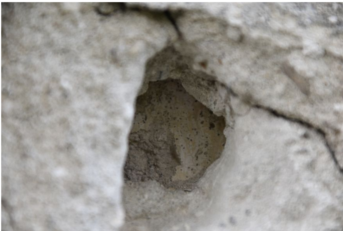
fot. 10: Odkrywka nr 21, elewacja wschodnia. Pod tynkiem widoczne warstwy malatury.
