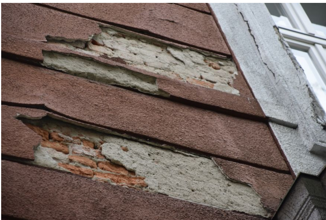
fot. 17: Naturalna odkrywka nr 25, elewacja wschodnia. W pasach pierwszego oraz drugiego piętra warstwy tynku są znacznie cieńsze.
