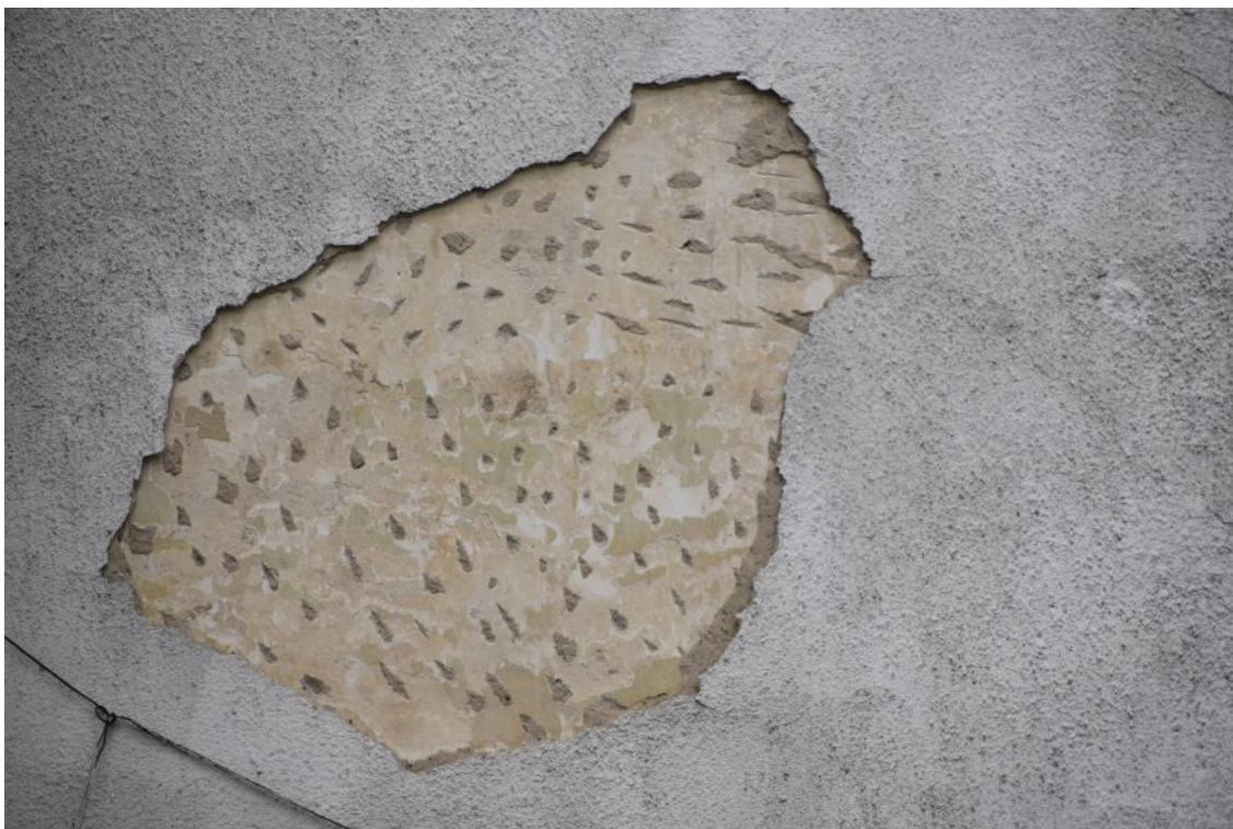
fot. 44: Naturalna odkrywka nr 34. Nasieki zostały wykonane w pierwotnym tynku. Nawarstwienia farby są podobne jak w pasie pierwszego piętra elewacji frontowej oraz bocznej (odkrywka nr 4 oraz nr 21).
