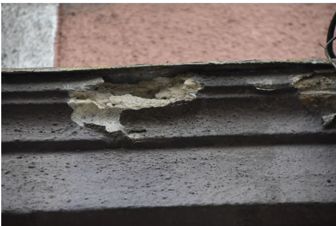
fot. 31: Naturalna odkrywka w obrębie gzymsu.
