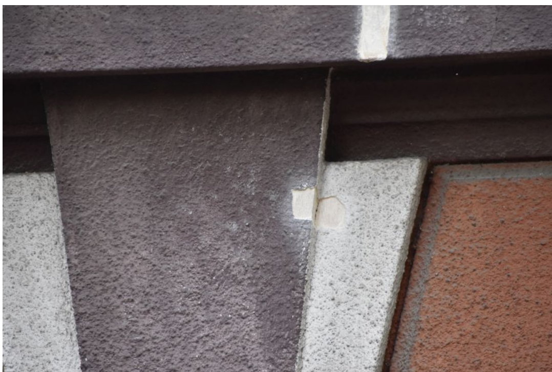
fot. 23: Odkrywka nr 30, elewacja zachodnia.
