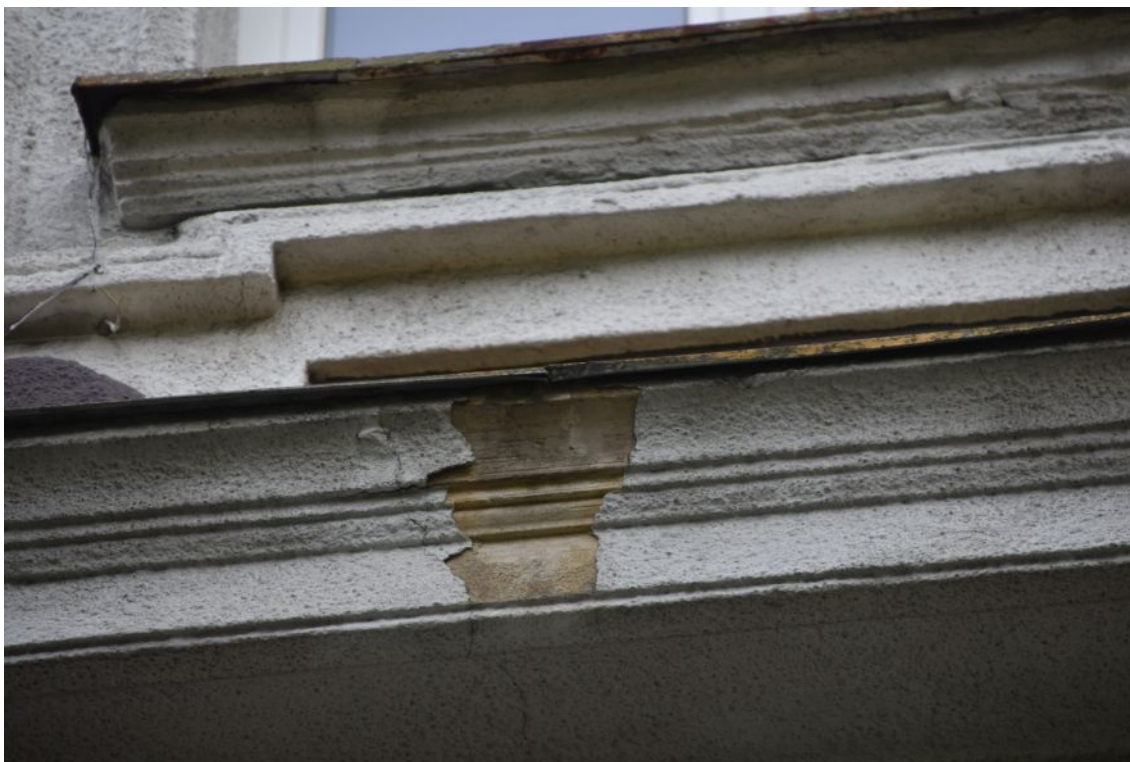
fot. 32: Naturalna odkrywka w obrębie gzymsu.
