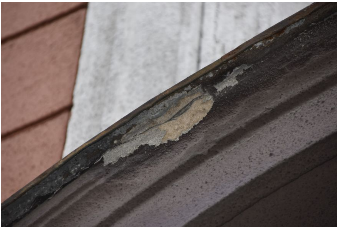
fot. 30: Naturalna odkrywka w obrębie gzymsu.
